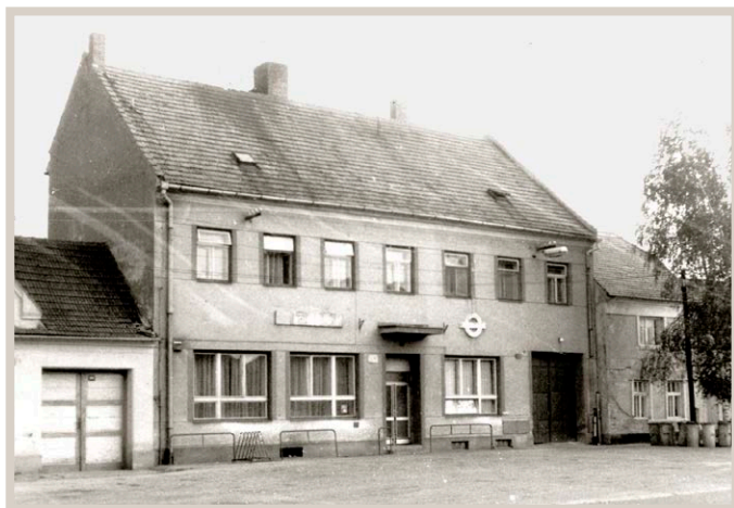
Stav objektu restaurace po roce 1989
